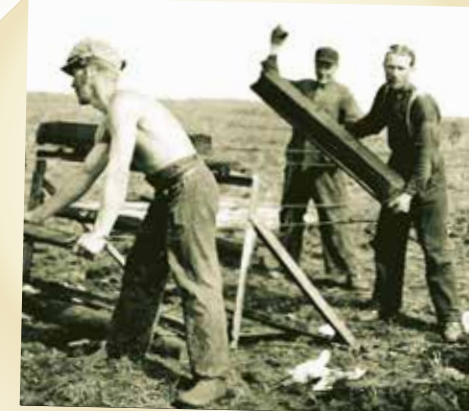
Handarbete med att pressa samman torven
